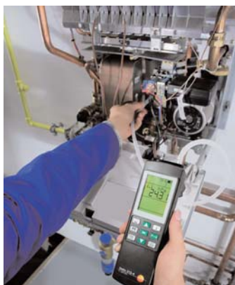
Kontrola připojovacího a provozního tlaku plynu
