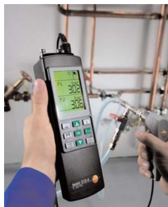
Zkouška tlaku na vodovodních a odpadních potrubích
